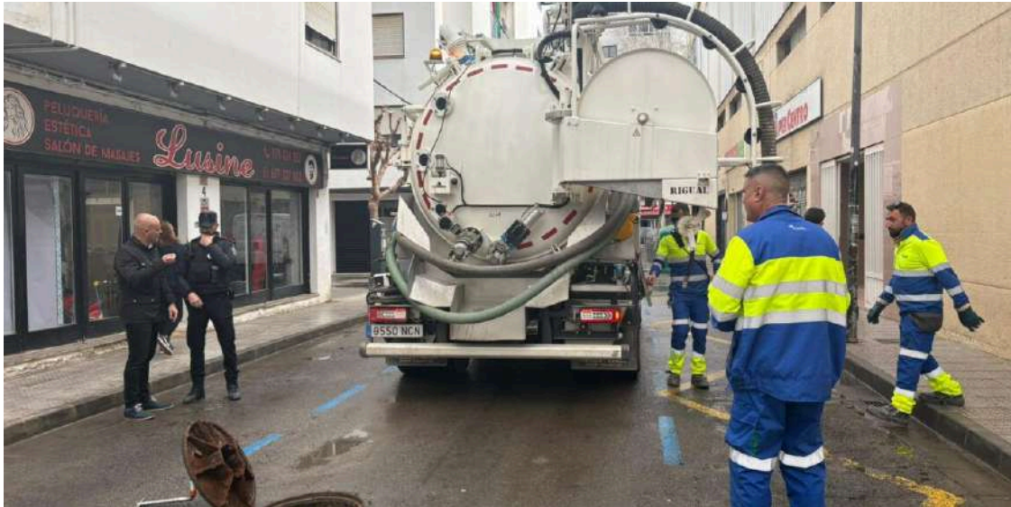
Limpeza de imbornales para evitar atascos cuando caigan las precipitaciones.
