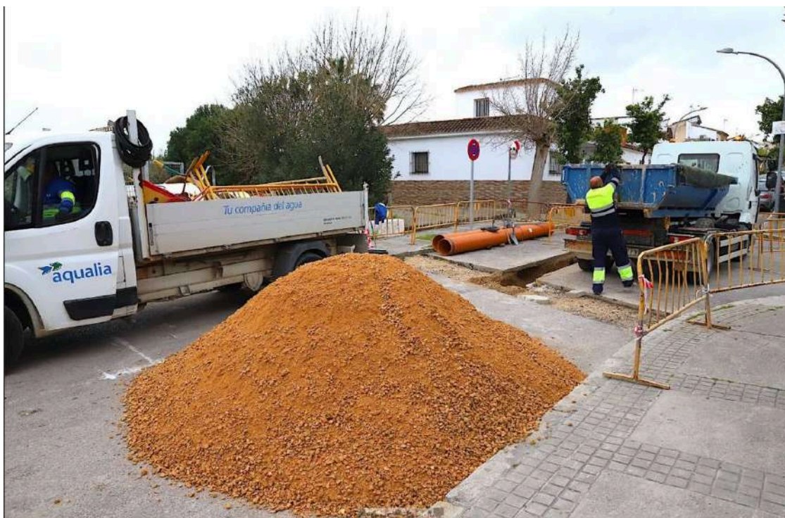
Operarios trabajan en Estella para solucionar los problemas de saneamiento.
