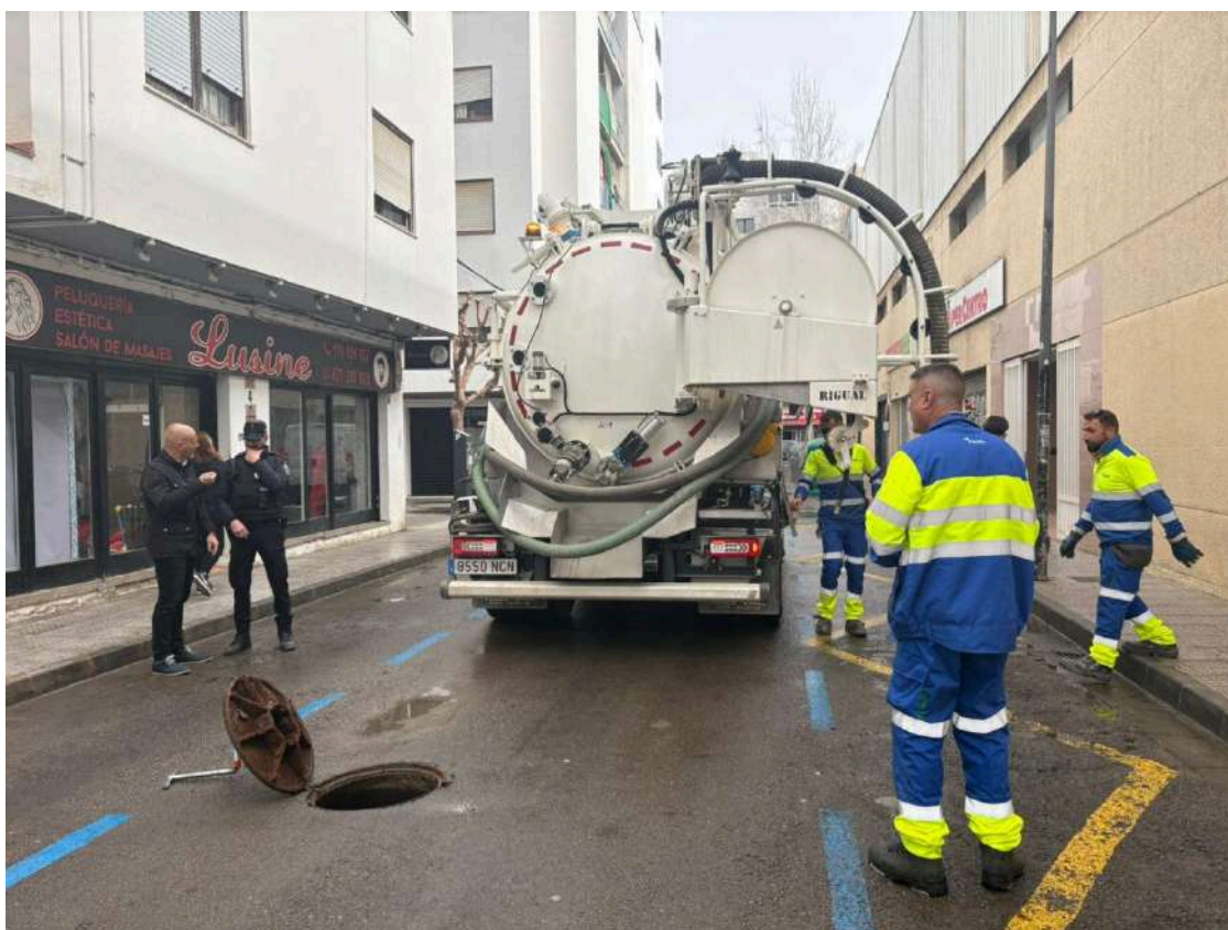
El Ayuntamiento refuerza la limpieza de sumideros y redes de pluviales para prevenir inundaciones ante la llegada del temporal.
